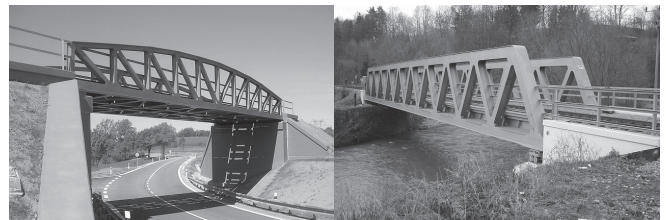
Abbildung 3 und 4: Beispiele von Fachwerksbrückenstrukturen.. Quelle: Railway bridges. Top Con Service [online]. 1992-2011 [Zugriffsdatum. 02.19.2012]. gefunden auf: http://www.topcon.cz/reference/railway-mos-ty.htm
